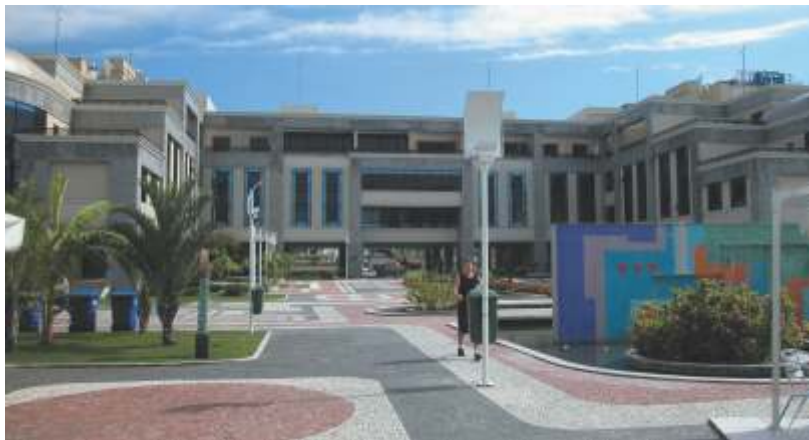
Vista do edifício onde se localiza o escritório da ELC no Rio
