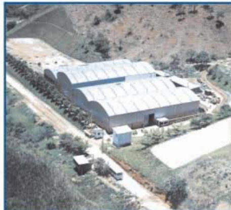
2ª fase da ELC: Consolidação da base física
